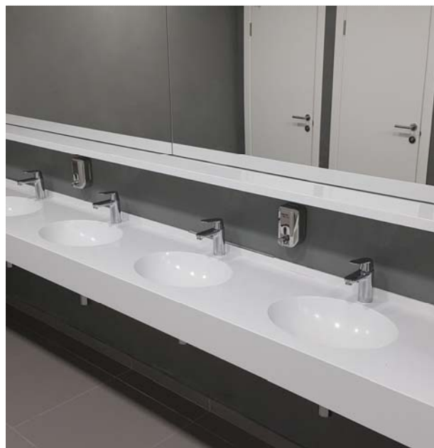
Проектирование, изготовление, монтаж столешницы с встроенными раковинами для санузлов
